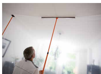
1. Systemstangen anbringen
